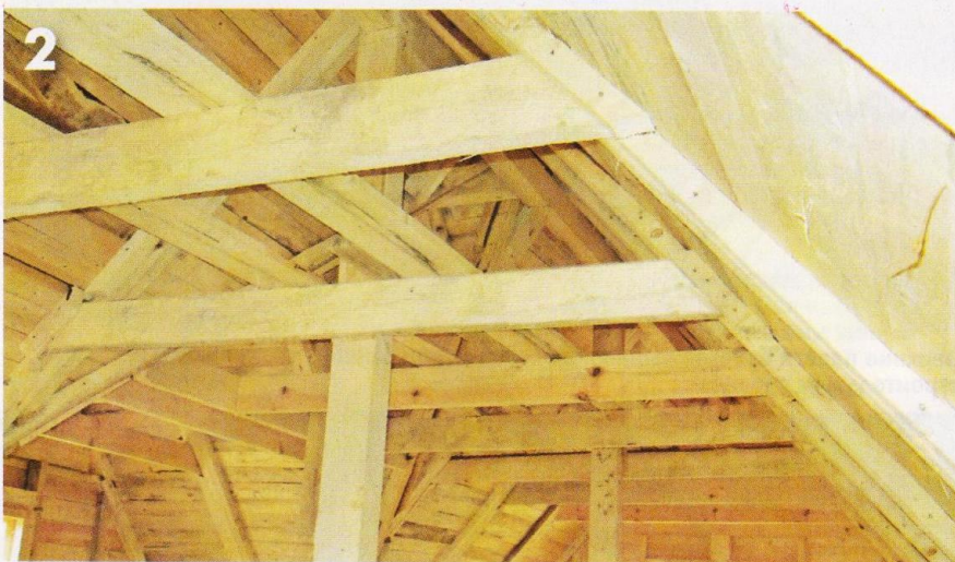
2 Нижние кромки затяжек в стропильных конструкциях лежат в одной плоскости и пригодны для крепления обшивки потолка.
