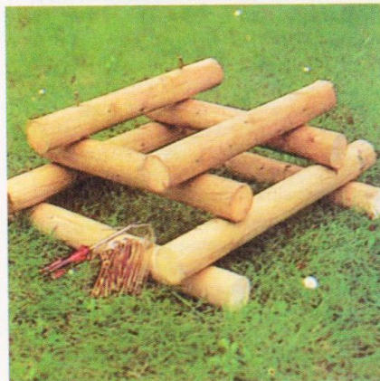
В 10 см от торцов сверлят отверстия под болты.
