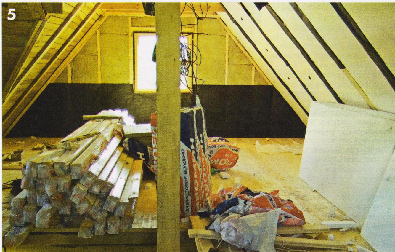
Пенопласт — лёгкий, плиты из него, плотно вставленные между стропильными ногами, даже нет необходимости надёжно закреплять: они не выпадают. С плитами минеральной ваты было бы сложнее.
