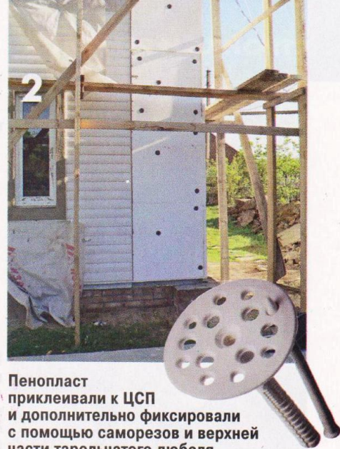
1 Основой для «мокрого фасада» послужила обшивка из цементно-стружечных плит
