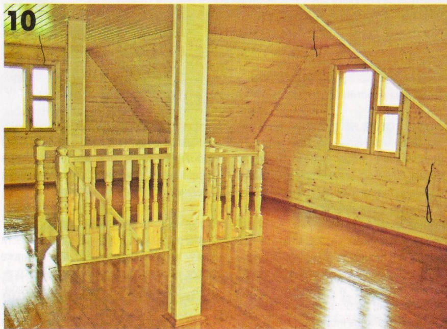
Светлая деревянная обшивка стен хорошо сочетается с тонированным полом. Осталось установить розетки, повесить светильники и занести мебель.
