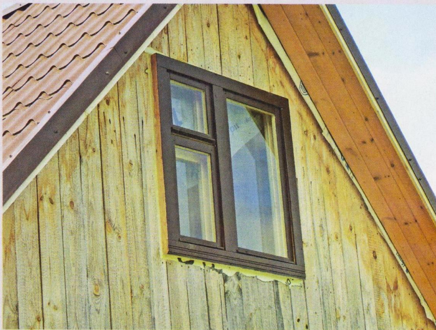
Кроме монтажной пены окно удерживается длинными саморезами, вкрученными сквозь оконную раму в раму каркаса.
